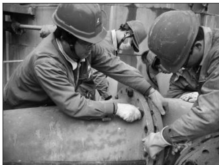
近日,氧化铝三分厂八车间对3号、4号脱硅槽进行紧急倒槽,大家克服天气严寒、任务繁重等困难,仅用了1个小时完成了外委3个小时的工作量。图为检修人员正在紧固法兰。摄影报道 邢建英 孟青菊
