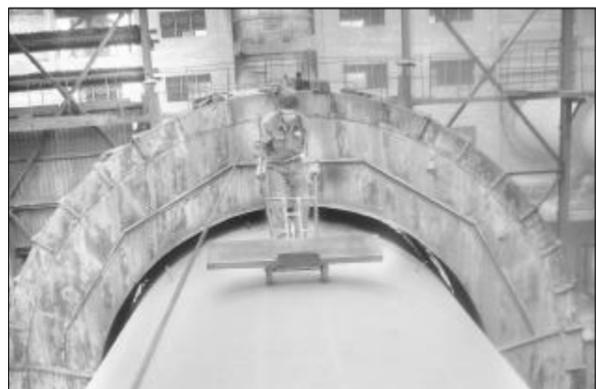
近日，检修分厂检修车间员工解放思想，打破常规，大胆创新，在2号熟料窑三档垫板更换任务中，采用四档电葫芦和自制推车相结合的办法，在安全的前提下，节省费用万余元，圆满完成了36块垫板的更换任务。图为员工在安全防护措施下，利用手推车在回转窑上运输垫板。摄影报道 杨陆平
