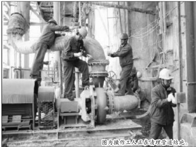
图为操作工人正在清理管道堵结。
