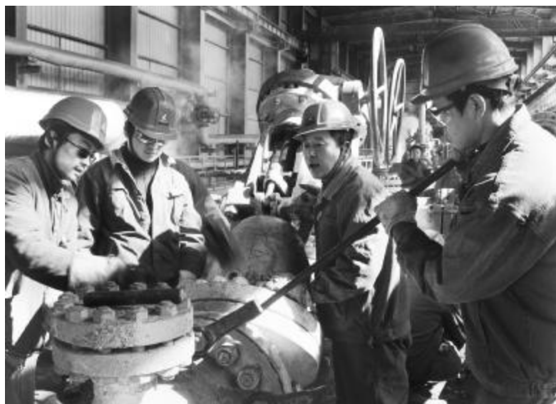
2月25日,20万吨氧化铝厂进行了年后的首次系统检修。包含原料磨、高压溶出、蒸发、沉降、分解五大系统的隐患消除与维护修理。检修从5日的0时开始到12时全面结束,共用时12个小时,处理问题100余项,为实现首季开门红打下良好的基础。图为20万吨氧化铝厂组织的检修人员,正对高压溶出系列管道进行设备消缺。摄影报道任卫红 吴旭龙
